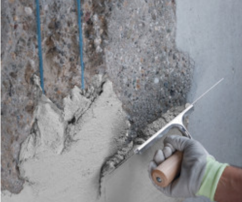
Påføring av Planitop Smooth & Repair Zero med sparkel
