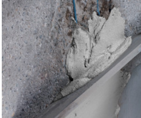
Utjevning av Planitop Smooth & Repair Zero med en rett kant
